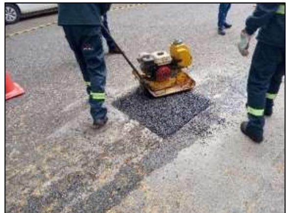
Conformação da massa asfáltica com placa vibratória
