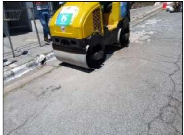
Conformação da massa asfáltica com rolo compactador vibratório
