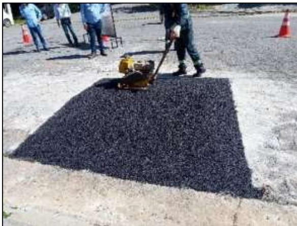
Conformação da massa asfáltica com placa vibratória
