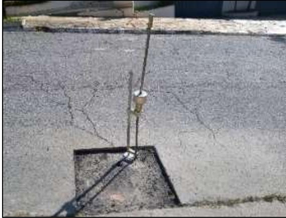
Teste de DCP efetuado. Resultados dentro das normas técnicas exigidas pela Sabesp
