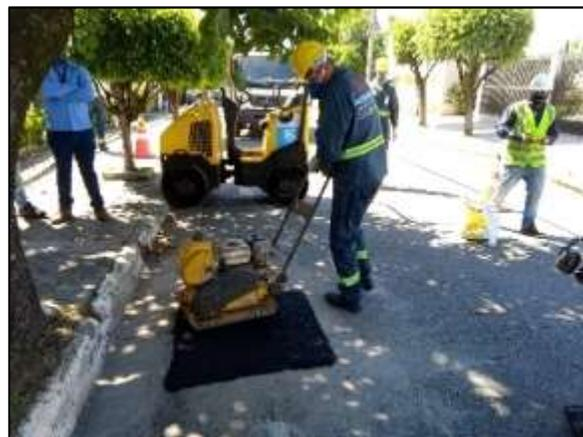
Conformação da massa asfáltica com placa vibratória
