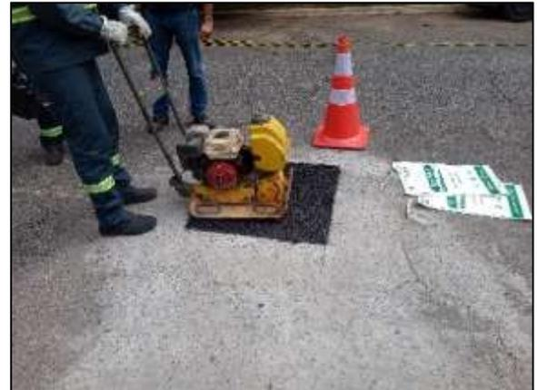
Conformação da massa asfáltica com placa vibratória
