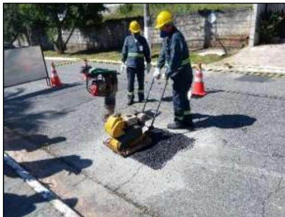
Conformação da massa asfáltica com placa vibratória
